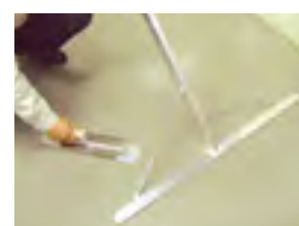
裏で頭張り作業
